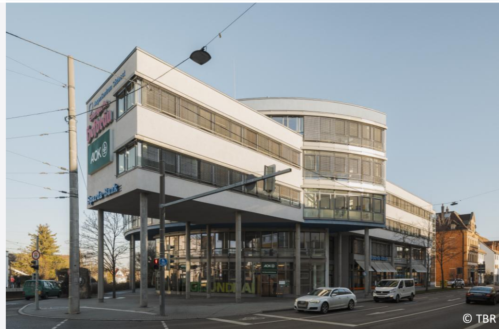
Ansicht Möhringer Landstraße/ Schillerplatz
