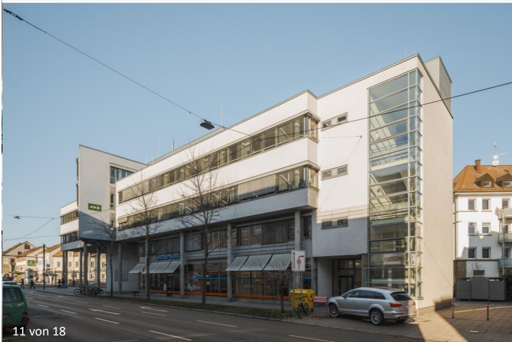
Ansicht Möhringer Landstraße
